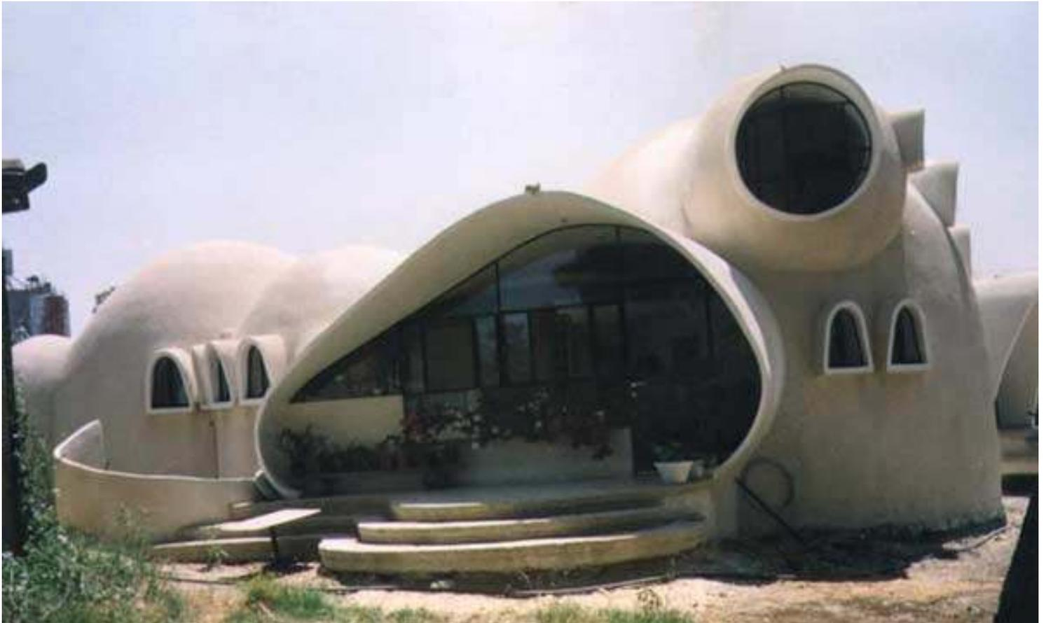
A técnica do ferrocimento é uma forma de se construir reservatórios, tanques e lagos, para armazenamento, tratamento e aqüicultura. Tem uma infinidade de aplicações: paredes, telhados, coberturas curvas, caixas, móveis, barcos, etc.
