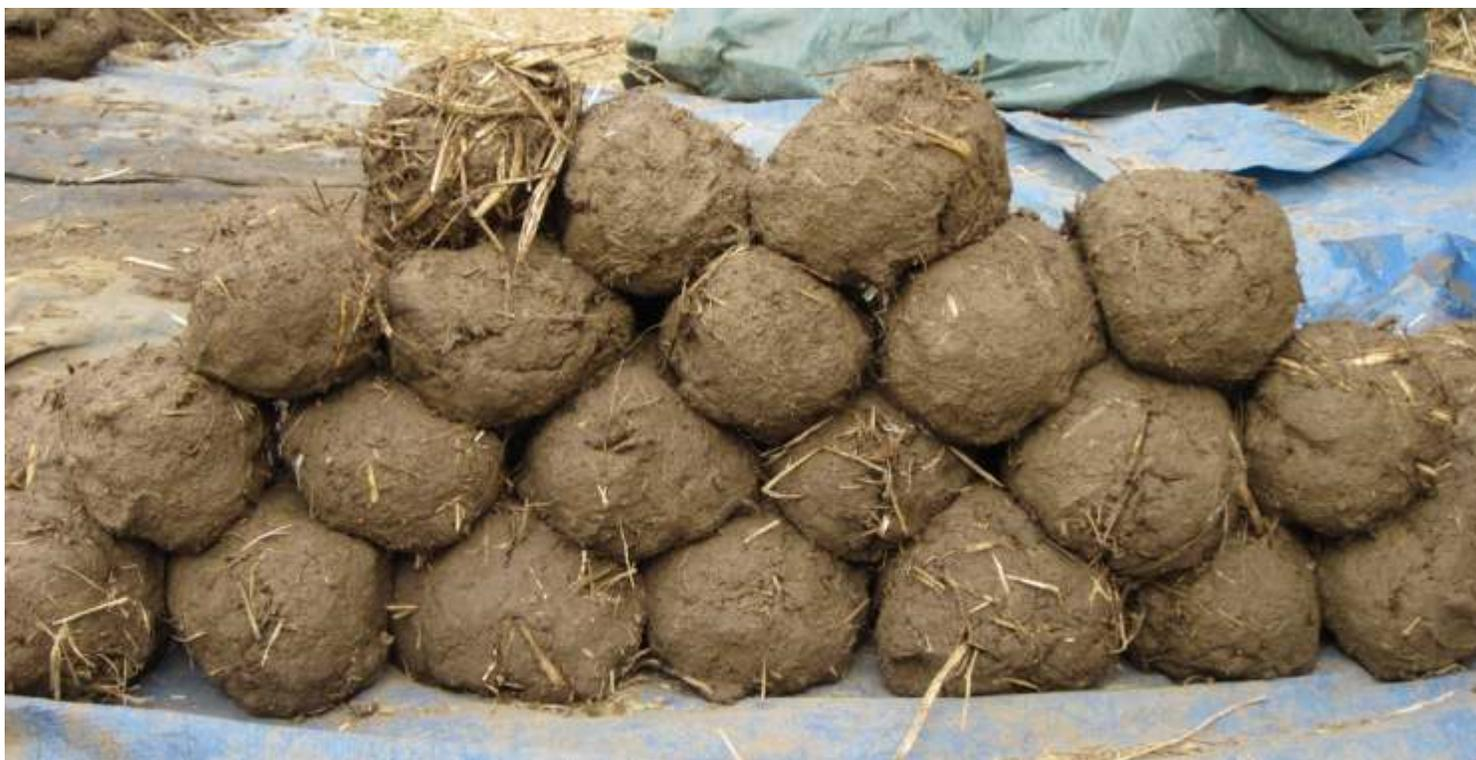
Uma mistura muito úmida vai dificultar na moldagem de suas formas quando estiver subindo a parede. Continue a pisotear a mistura. O pisoteamento vai mesclar as partículas de argila e areia.
